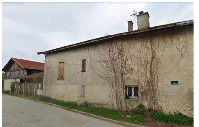
6 - Ancienne bâtisse agricole
